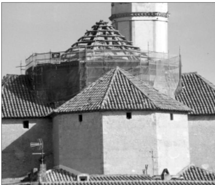
□ De l'actual església, l'any 1790, només n'hi havia construïda una part. En la fotografia veiem l'estructura de l'encavallada de la cúpula, apareguda en les darreres obres de la teulada
