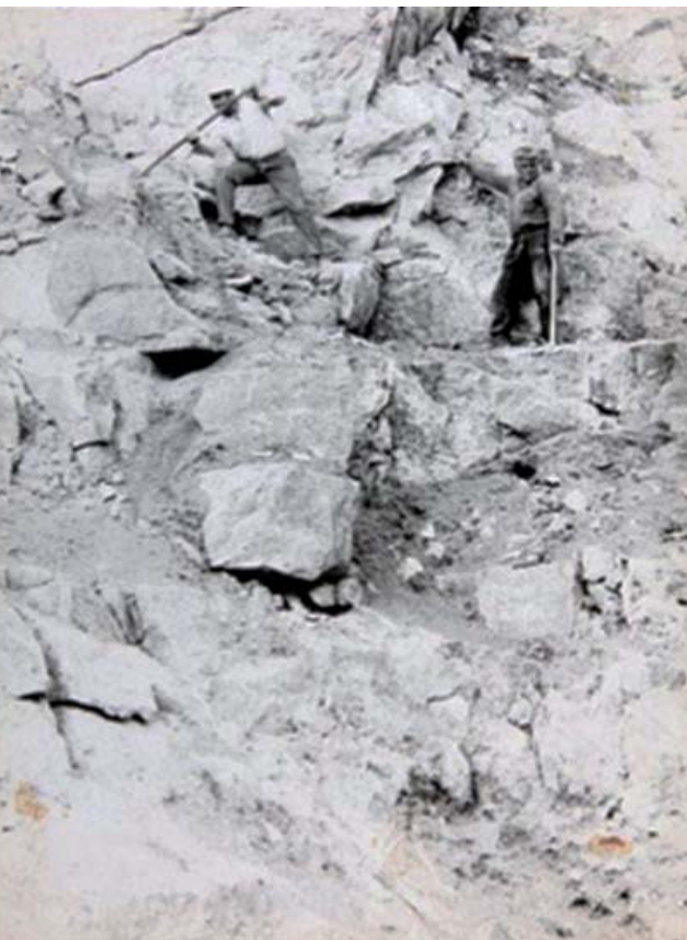
Dos treballadors a la pedrera del Cente arrancant la pedra amb perpalines i fent palanca. Any 1964. || Font: Col·lecció L'Abans. Autor i fons: Ramon Llinares Umbert
