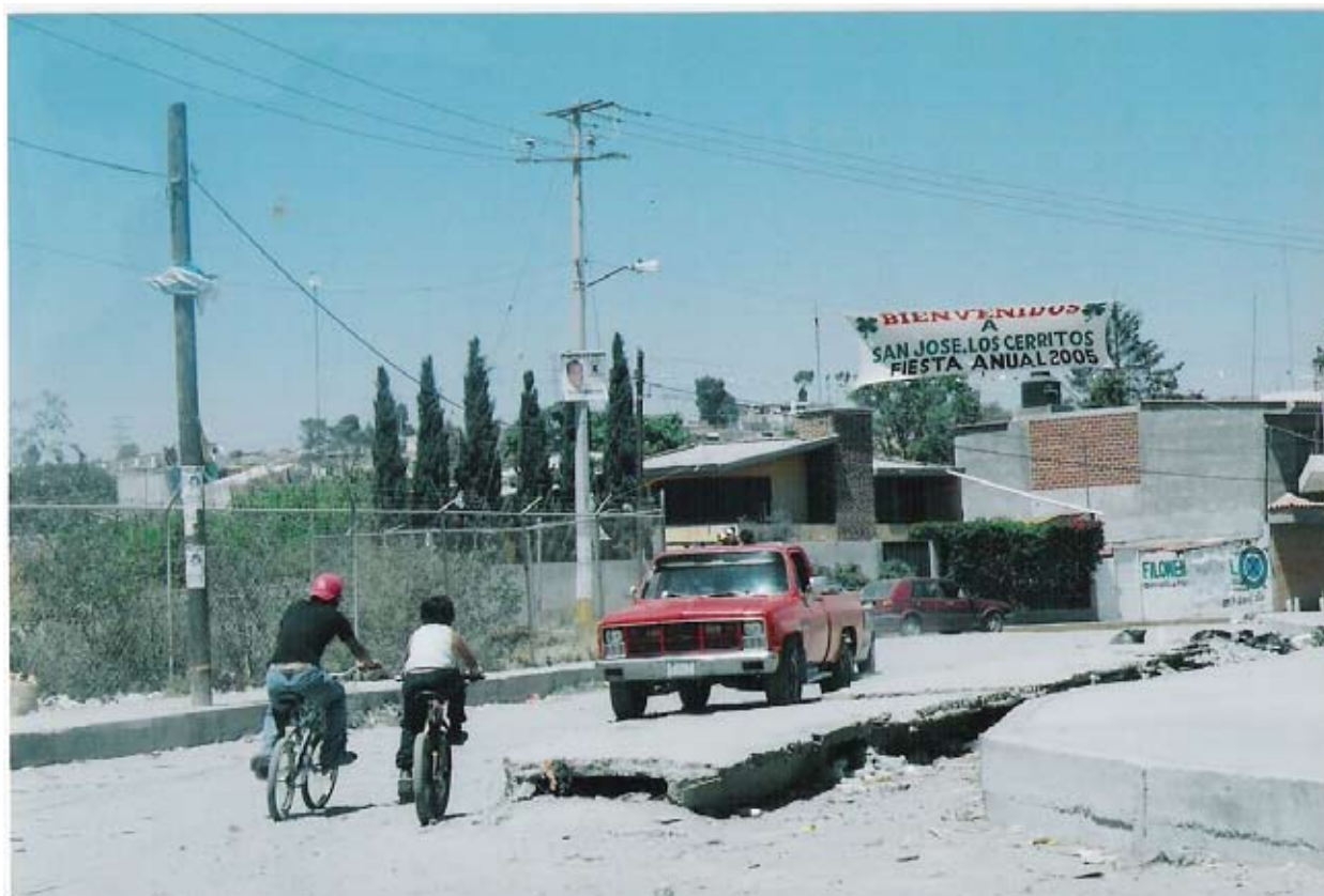
Imagen 1. Puente realizado por los habitantes de San José los Cerritos para conectar al asentamiento con la ciudad de Puebla. Foto: Flores, Lourdes, en revista PRAGMA: 2009
