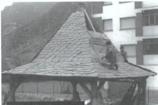
Ribera de Cardós. Recuperació del llo- sat del teulat del campanar per a un restaurant.
