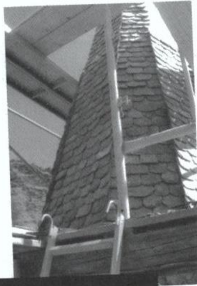
Sant Llorenç d'Isabarre. Es va restaurar el campanar canviant-ne tota l'estructura original per tornar a col·locar les lloses de pissarra.
