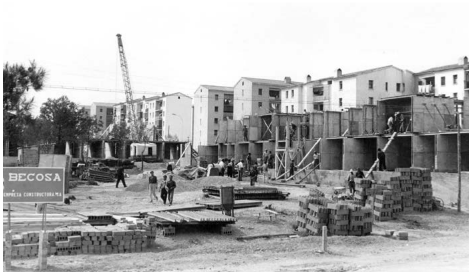
Construcció dels habitatges del barri de Sant Llorenç del Munt. Gener del 1964 Font: Arxiu Municipal de Terrassa. Col·lecció fotogràfica Baltasar Ragón.
