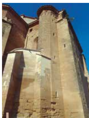
Fig. 5 - Torre amb planta poligonal que allotja una escala de caragol per accedir a la primitiva teulada de l'església
