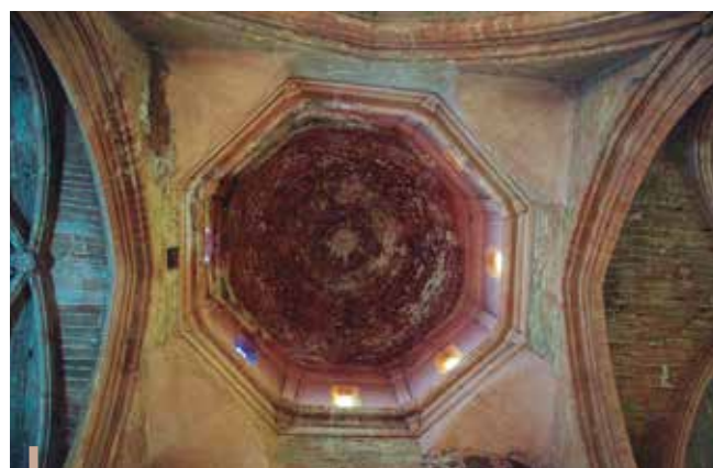
Fig. 11 - Cimbori situat al transepte, sostingut per quatre trompes que fou refet després de la Guerra Civil
