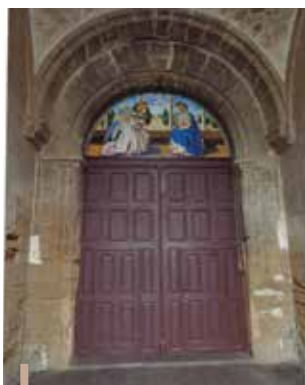
Fig. 10 - Portal principal d'accés a l'interior de l'església, del segle XVI
