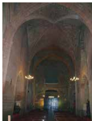
Fig. 3 - La nau del temple té actualment tres trams; un cobert amb volta de creueria i els altres dos amb sengles voltes catalanes en substitució d'una altre del mateix tipus
