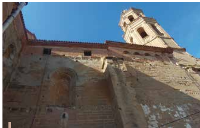
Fig. 2 - Pany de paret de l'indret nord on es poden observar diferents tipus de construcció i indicis d'edificacions enderrocades
