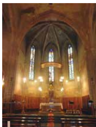
Fig. 4 - Absis principal amb la volta de creueria i els tres finestrals al fons
