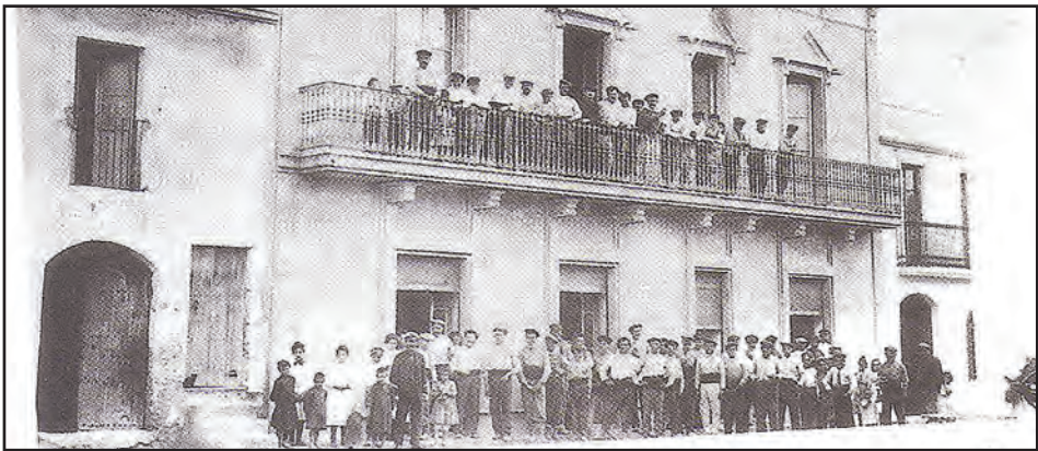
Edifici central de la Cooperativa l'any de la inauguració de l'edifici de la Cooperativa (1895 es va fundar l'entitat i l'edifici es va construir cap el 1905). Foto cedida per M. Antonietta Casasús.
