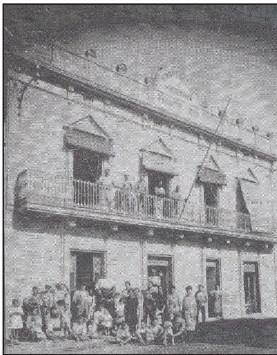
Façana de l'edifici de la Cooperativa. La primera i segona portes de l'esquerra donaven accés a la botiga. La següent porta era per pujar al cafè ubicat al primer pis i la porta següent, correspon a l'entrada del forn de pa.
