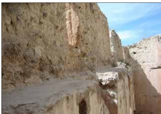
Figura 5a y 5b. Vista de los muros modificados de la fachada principal, así como de las incrustaciones de restos cerámicos en el tapial original.
