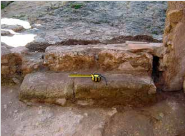
Figura 11. Sillares que conforman el umbral de acceso al patio de armas. Época contemporánea.
