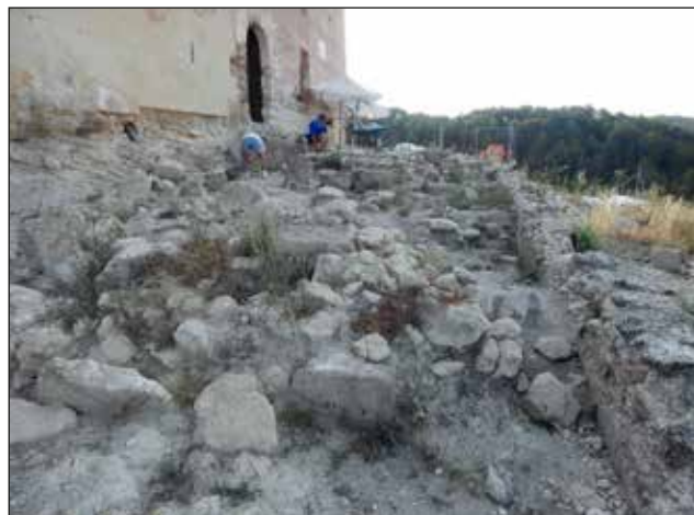
Figura 14. Inicio de los trabajos de limpieza de la zona.
