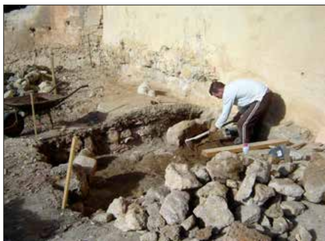
Figura 9. Trabajos de excavación de la zanja con procedimiento arqueológico.
