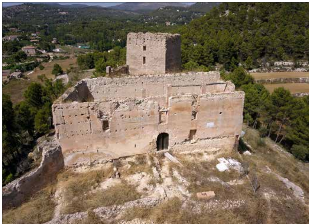
Figura 8. Apreciamos a ambos lados de la puerta principal, una línea de aspilleras de palo, en ocasiones truncadas con a la apertura de vanos pertenecientes al uso de la nave principal como masía.
