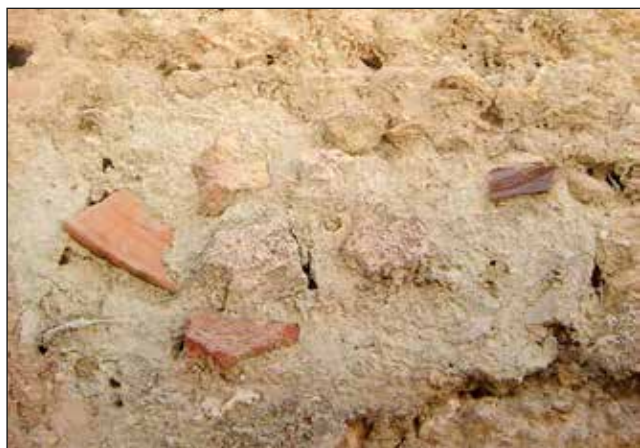
Figura 5a y 5b. Vista de los muros modificados de la fachada principal, así como de las incrustaciones de restos cerámicos en el tapial original.
