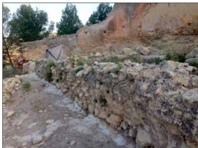
Figura 15. Restos de muro construido con técnica de tapial, probablemente uno de los más antiguos localizados en el recinto de la fortaleza. En la actualidad, hace de pantalla y frena las aguas de salida en los procesos de lluvias intensas.
