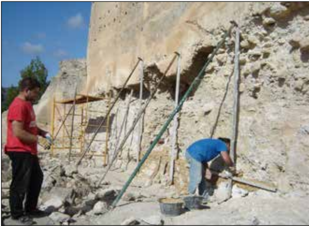
Figura 6. Reparación de la fachada principal.
