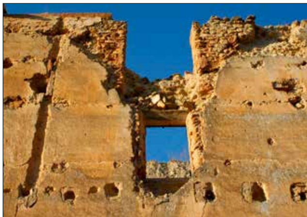
Figura 4. Apertura de vanos durante el proceso de creación y reforma de la masía (s. XIX) que destruye los lienzos de tapial originales.
