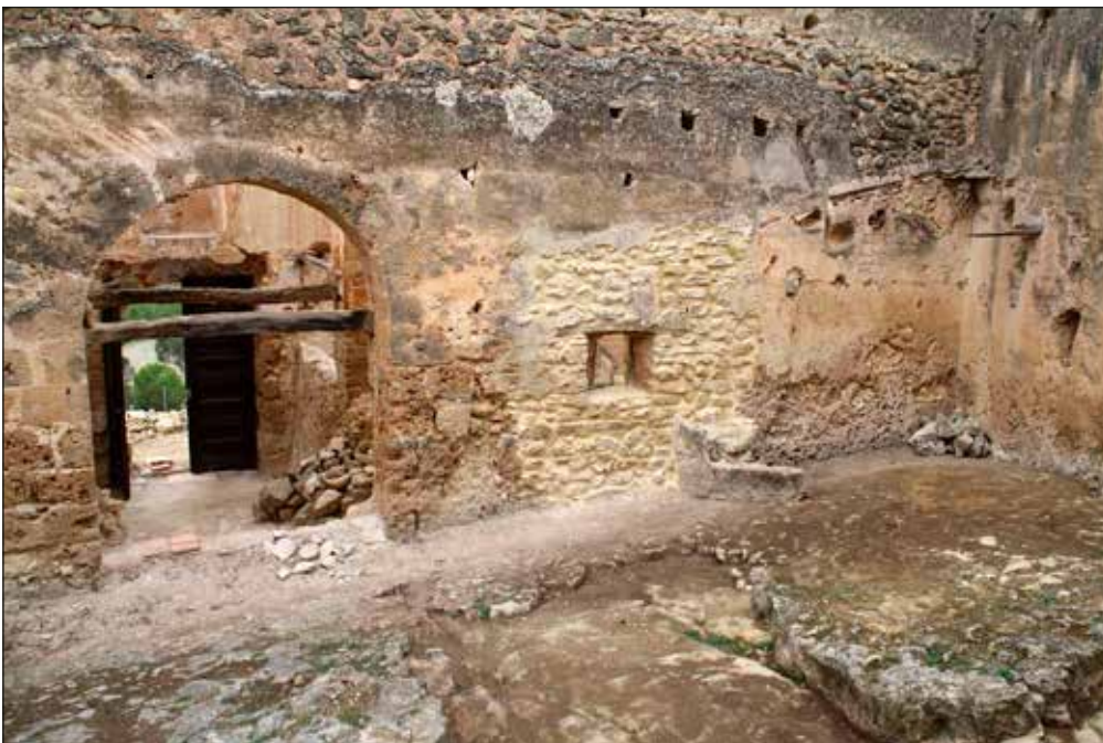
Figura 7. Trabajos en el recinto interior.
