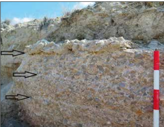
Figura 5. Detalle de las capas de hormigón.
