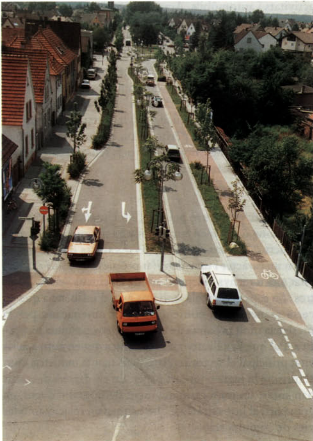
Foto 8: Integració de tres tipus de circulació (bicicletes, vianants i cotxes) amb un tractament diferenciat de l'espai dedicat a cadascun, que n'augmenta així la seguretat. Bedburg (República Federal d'Alemanya) (Foto: autor)
