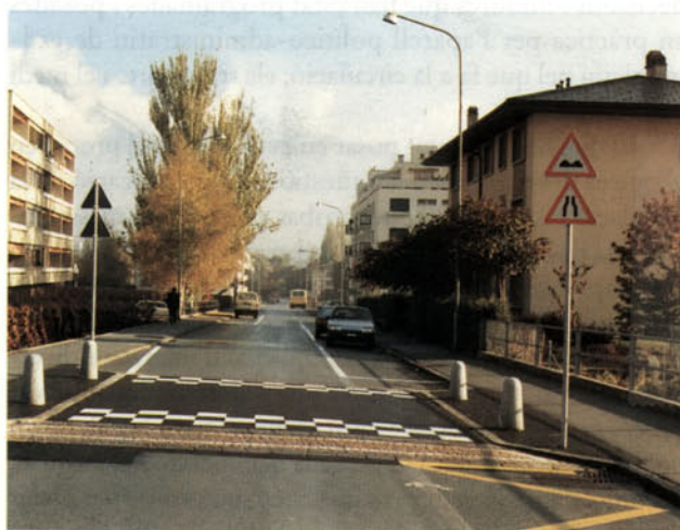
Foto 5: Petita elevació de la calçada d'un carrer residencial de Sierre (Suïssa) per tal d'evitar l'excés de velocitat i protegir els vianants (Foto: autor)
