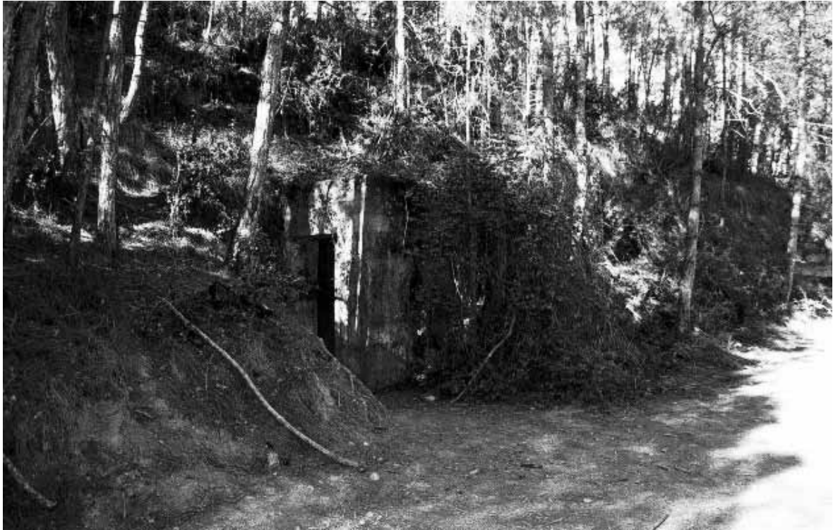
A la foto, una de les dues entrades formigonades del refugi que van excavar els presoners del Batalló Disciplinari de Clariana de Cardener.
