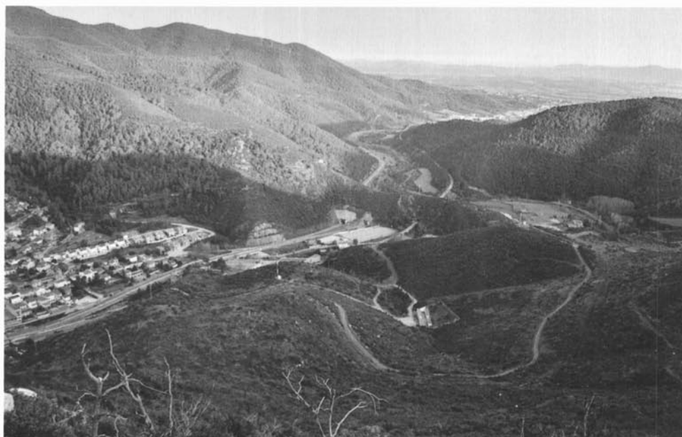
Túnel del Figueró. Espai que pot permetre la connexió entre banda i banda de la carretera C-17. (Fotografia: M. Parés)
