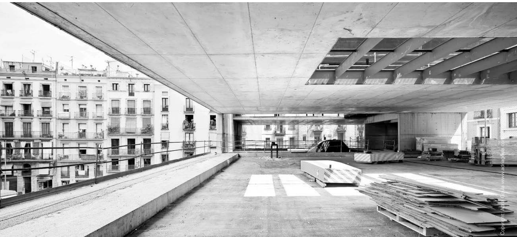
Nou edifici El Raval. Construcció edifici interior.
