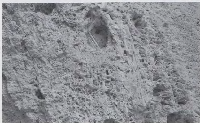
Foto 3. Detalle de los travertinos.
