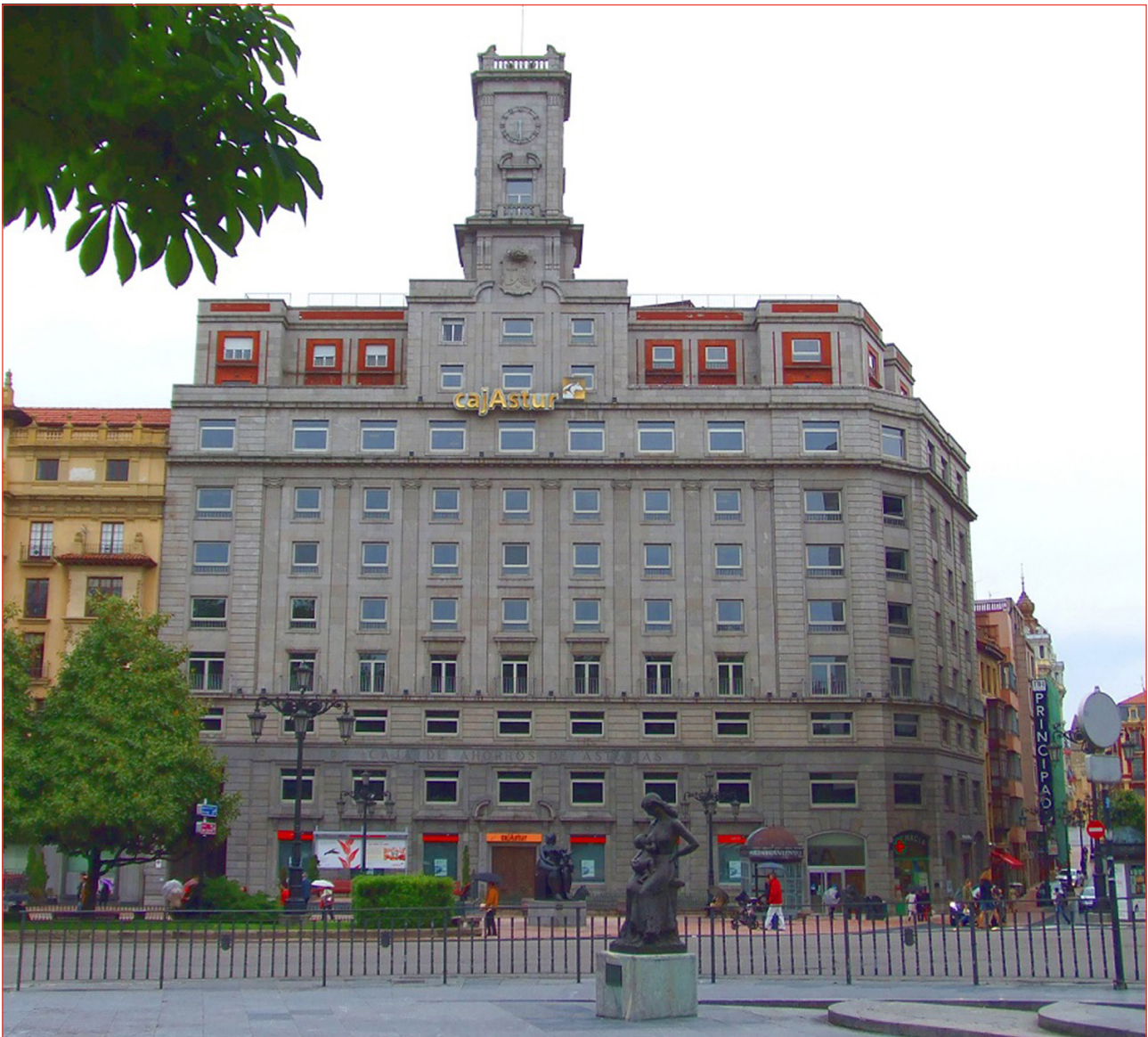
Figura 1. Edificio de la Caja de Ahorros (1946). Fuente: el autor.
