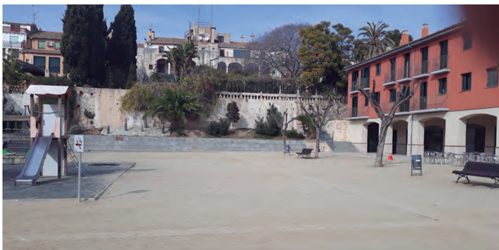
Figura 9. Vista general de la plaça Martí Royo amb el mur de contenció del jardí de Ca Macaya
