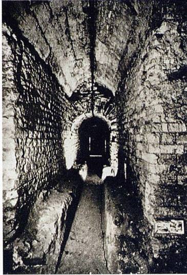
Galeria de sanejament de Lutetia.
