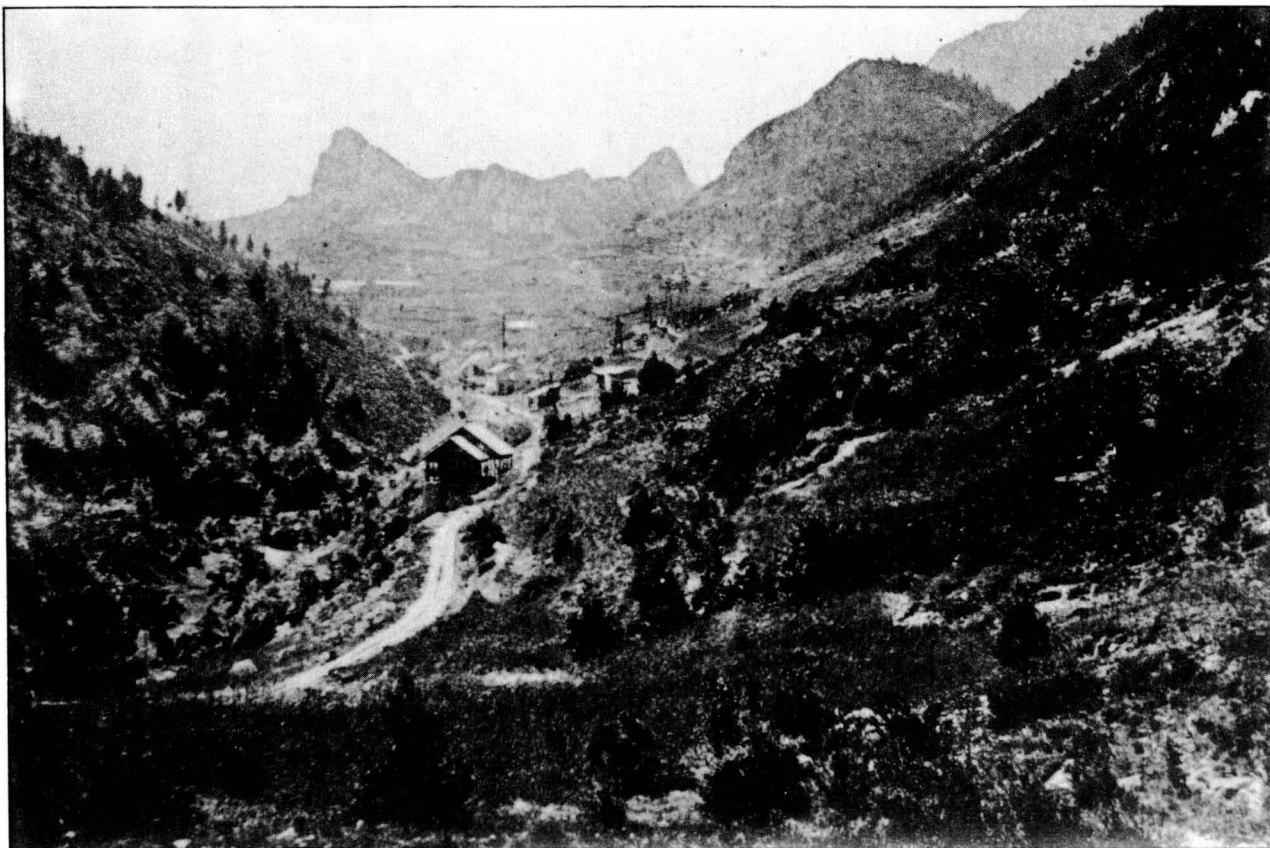
"Estació Intermedà de la Solana". En el fons s'hi veu el complex de la Cantina; més avall la mina Pepita, Teuleria, forns d'obra i ciment, edifici de la màquina de vapor, començament dels pisos i magatzems. A la dreta es destaquen les torres del cable aeri que amb vagonetes baixaven el carbó de la mina del Graell. Des d'aquesta estació s'enviava al Carregador de Les Graus o Colònia de La Vall, on començava el ferrocarril miner (tracció animal i plans inclinats) per a portar les vigues i el carbó a la Gran Serradora que l'empresa tenia a Cercs per facturar la producció en els Ferrocarrils Catalans. Des d'aquesta Serradora hi havia línia telefònica fins a Peguera.
