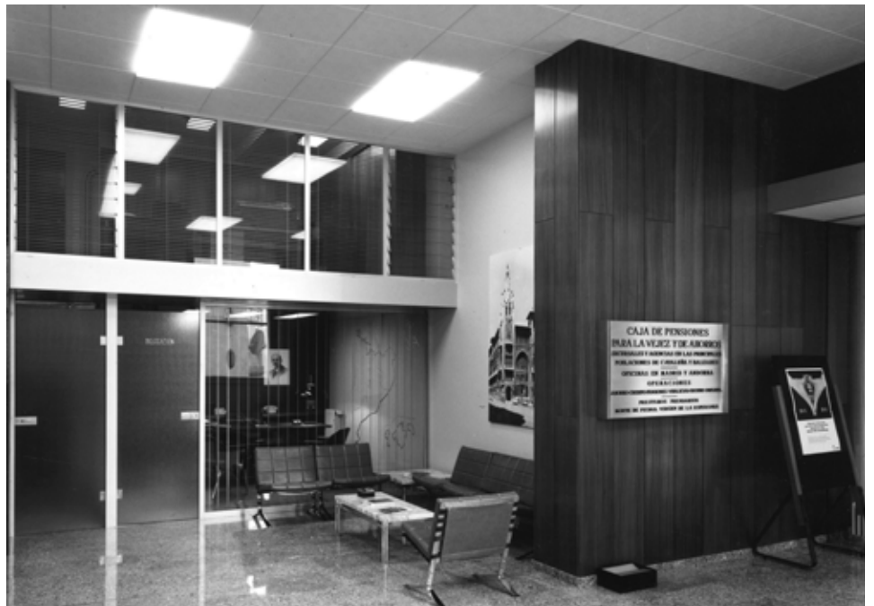
L'any 1968 es van fer obres a l'oficina de la Plaça de les Fonts, traient les columnes de l'entrada i les reixes interiors. COL·LECCIÓ CLIMENT VILELLA CAPALLERA.
