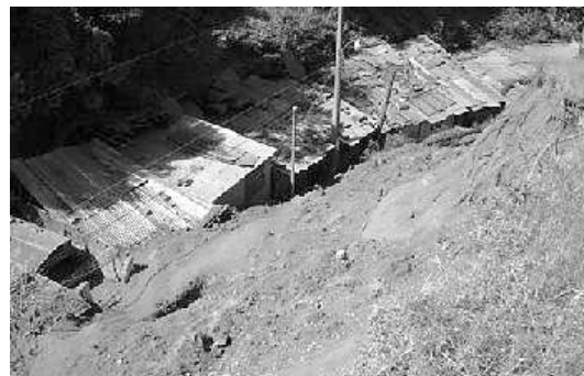
Figura 4. Deslizamiento de la cárcava del Hormiguero. Destrucción de la escuela de Bellavista. Fotografía Roger Mata
