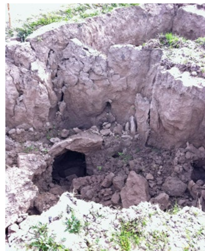
Fig. 4.- Vista de unos de los puentes de tierra, en el hueco producido por el desmoronamiento del terreno por encima, como vestigio del conducto subsuperficial que existía (tramo sur).
