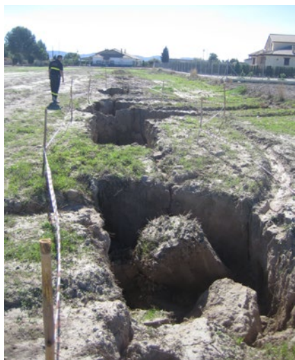
Fig. 3.- Vista de los huecos mayores producidos (tramo sur).
