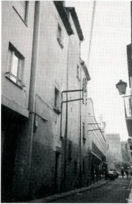
Fig. 4. La façana nord del que probablement devia ser l'edifici de la cúria i notaria dóna al carrer de l'Hospital. Al fons es pot veure la torre del Fum del conjunt monàstic.
