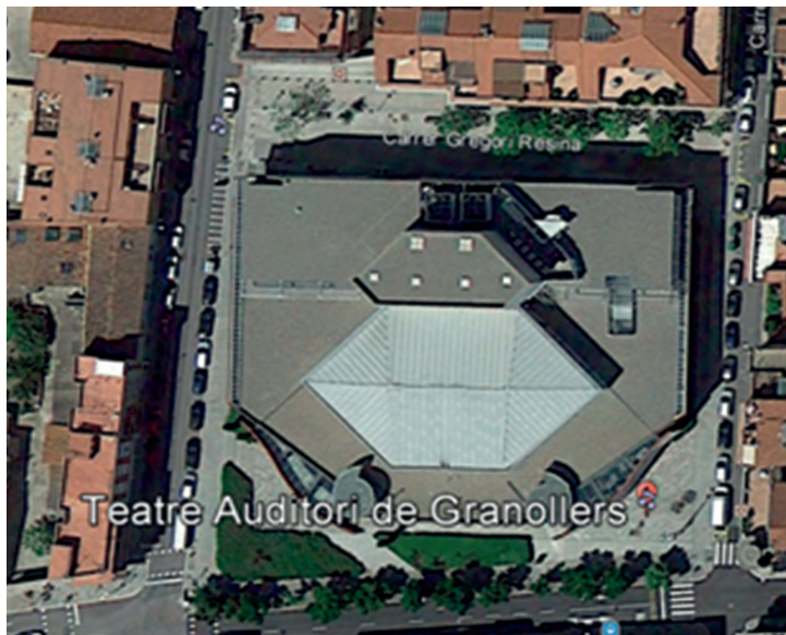
Fig. 2. Vista aèria del Teatre Auditori de Granollers.
