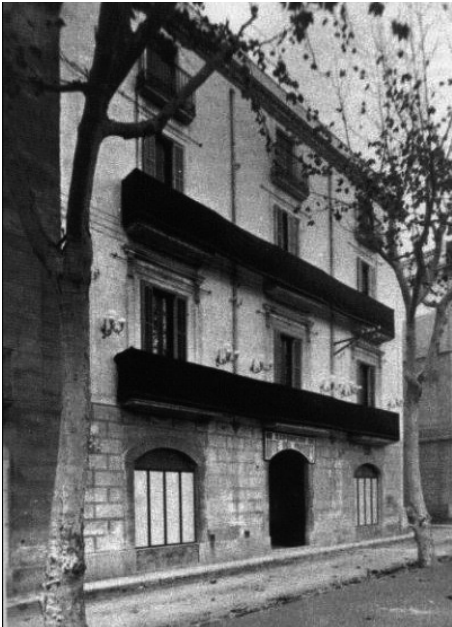
Edifici de l'Ateneu a la Rambla Principal de Vilanova i la Geltrú on s'instal·là l'Escola Graduada de Nens l'any 1932
