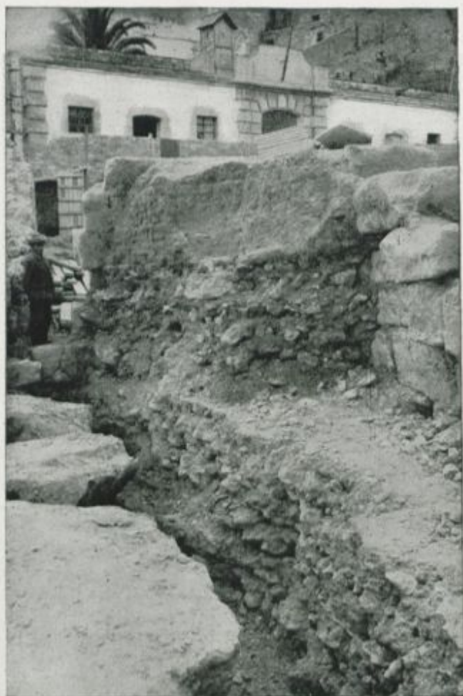
Corte de la muralla que se conservará dentro del Museo en construcción. Se distinguen perfectamente las dos clases de relleno, el inferior de piedras y tierra y el superior de adobes
