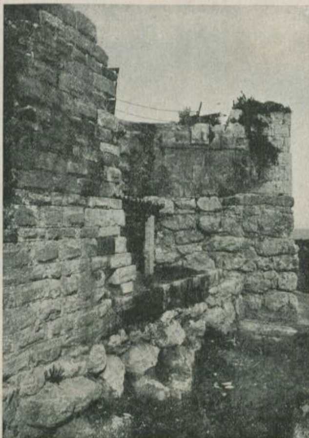
Consolidació de la muralla i torre de Sant Magí. Un cobert protegeix un massís de toves de l'estructura interior
