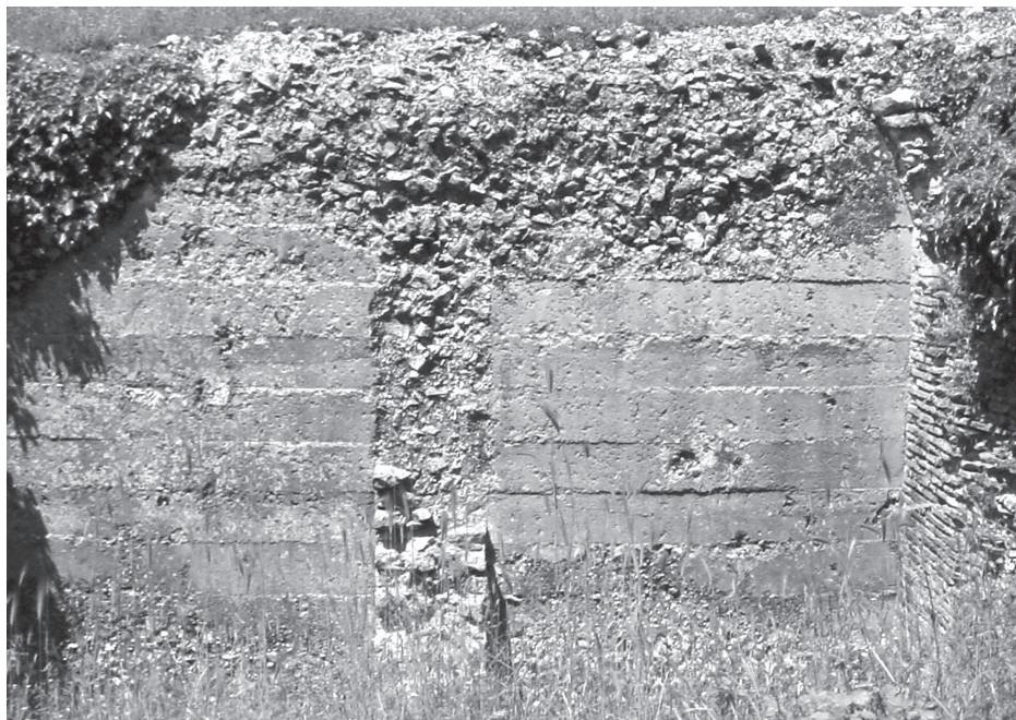
Figura 1. Muro en opus signinum realizado con la técnica del encofrado (GIULLANI 2006).
