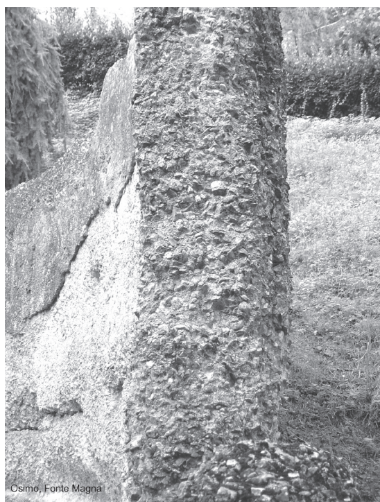
Figura 2. Sección de un muro en opus signinum (GIULLANI 2006).
