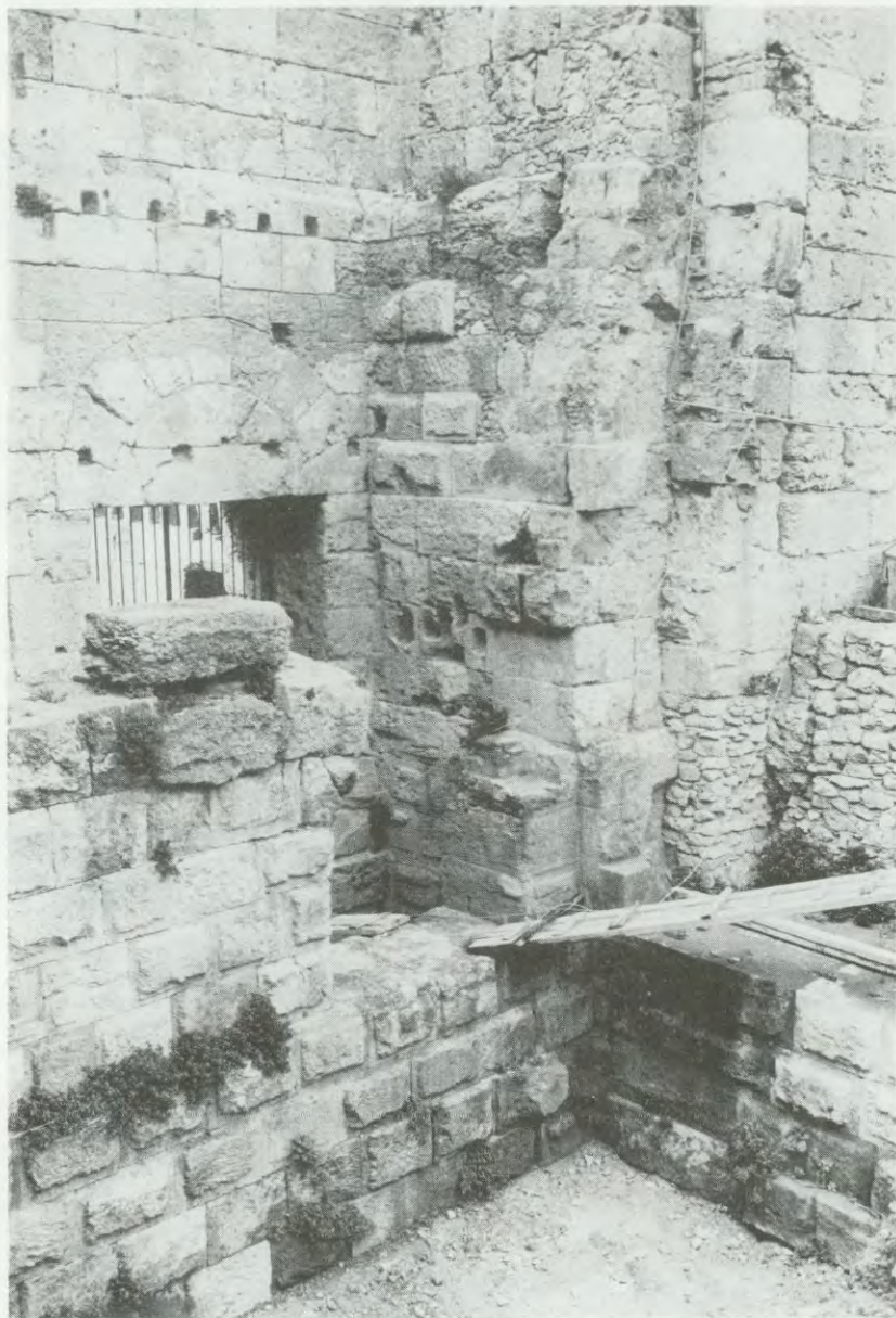
Foto 10. Tarragona, «Casa de Pilato», Plaza del Rey, muros romanos del «Foro de la Provincia». Inst. Neg. 5-72-22.
