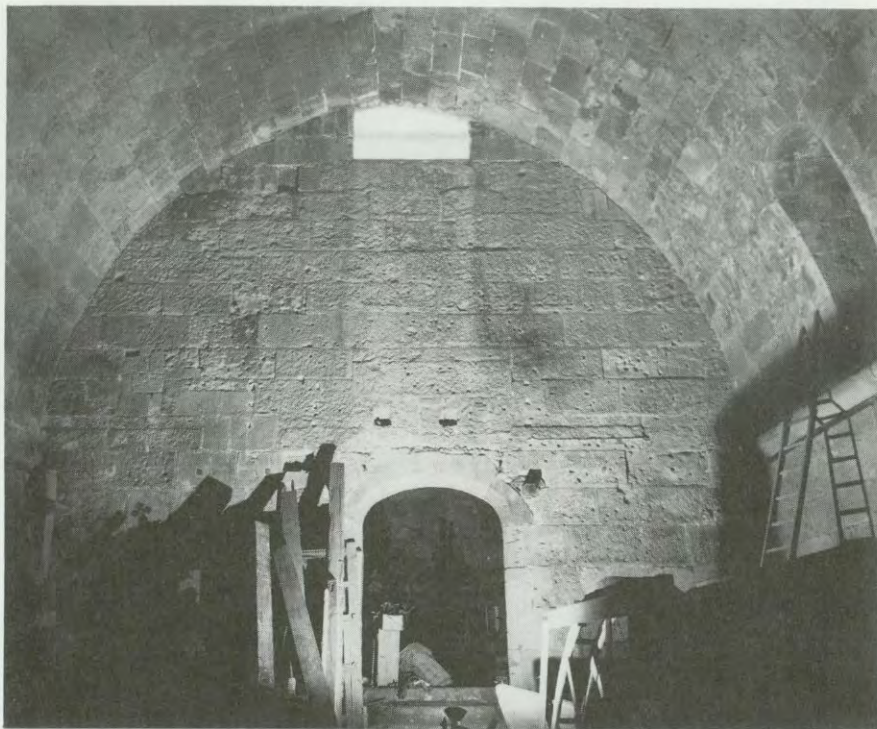
Foto 11. Tarragona, Catedral. Muro Norte del refectorio con orificios para la sujeción de las placas de mármol. Inst. Neg. R 186-71-4.
