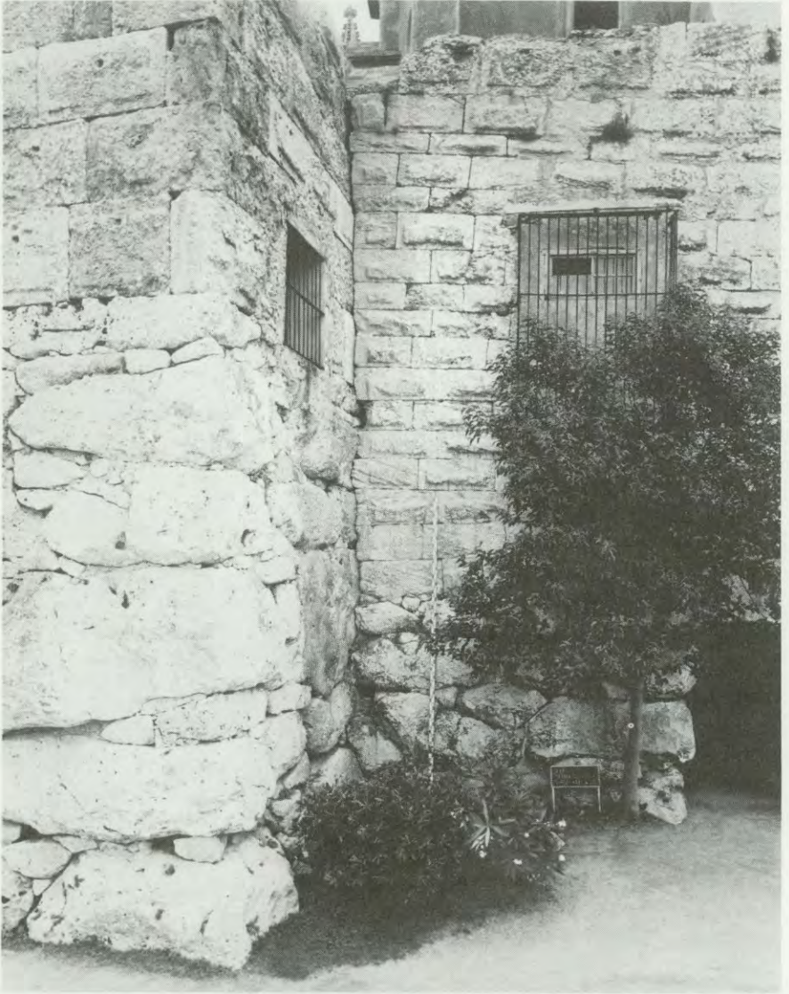
Foto 3. Tarragona, muralla. Torre del Cabiscol y tramo de la 2. a fase de la muralla (adosada a la torre) con la portella. 1974. Inst. Neg. 21-74-1.
