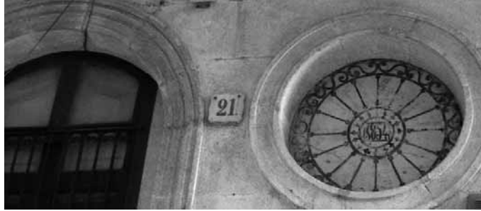
Figura 5. Estuc pintat simulant una reixa de ferro, al carrer de la Llibreteria, núm. 21 (1854).
