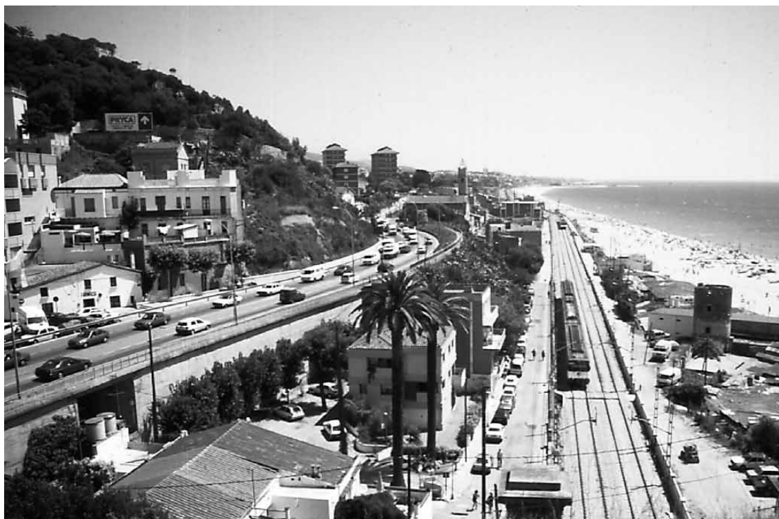
Fig. 2. L'efecte barrera de les infraestructures lineals de transports que solquen el litoral del Maresme és molt important. Per damunt d'una IMD de 1.000 vehicles per dia, ja és important, i quan supera la IMD de 10.000 ja esdevé pràcticament infranquejable per als vertebrats terrestres.
