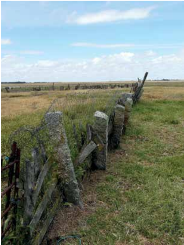
Figura 14. Tanca amb pilastres de granit que “ballen” amb els moviments d’expansió-retracció d’aquest sòl amb argiles expansibles, Salamanca (foto J. Porta).
