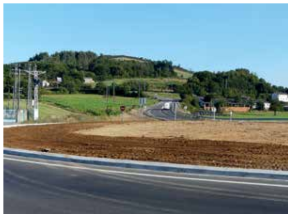
Figura 3. Tècnica de decapatge aplicada en l'enjardinament d'una rotonda, Lugo (foto J. Porta).
