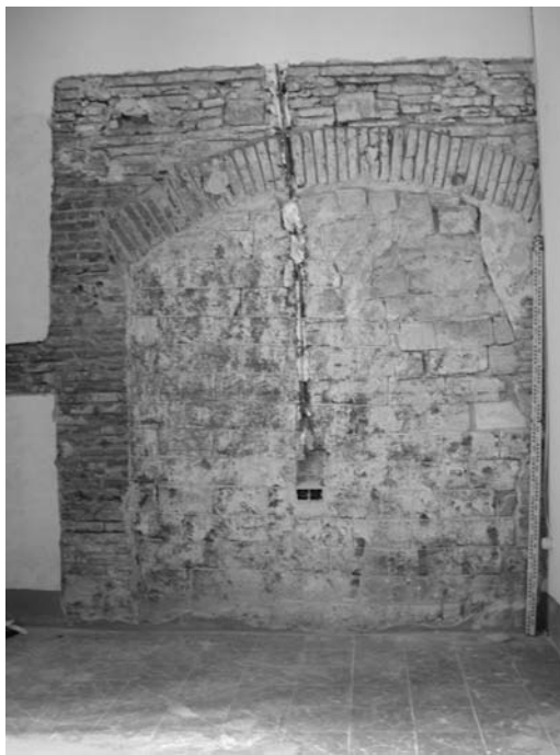
Vista de la porta localitzada a la cala 17 (àmbit D1).
