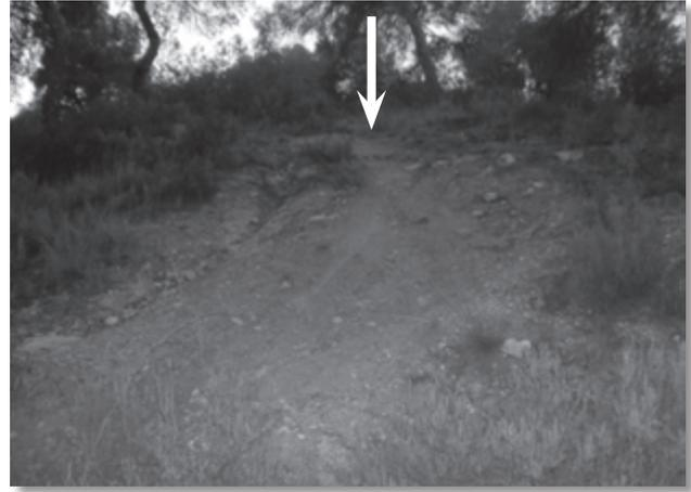
**Fotografía 2.** La presencia de una curva cerrada con una pendiente pronunciada favorece las ampliaciones del trazado principal con la correspondiente pérdida de cobertura vegetal
