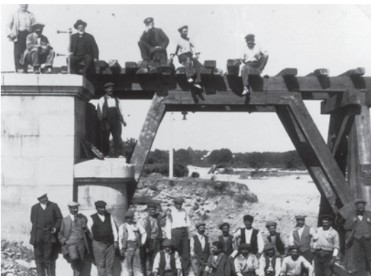
El pont de la riera, el 1913, en reconstrucció després d'una riada. El Pau hi va treballar, com altres de Cubelles.
