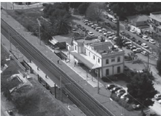
Fotografia general i aèria actual de l'estació de Cubelles.
