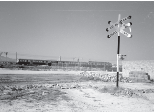
El camí i el pas nivell de la Mota de Sant Pere van ser suprimits arran de la construcció del Poliesportiu, a finals dels anys 70.
