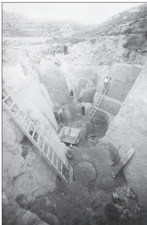
Grup d'obriers arreglant un dels avencs descoberts. Una vegada deixat el substrat el més llis possible, l'impermeabilitzaven amb ciment o paviments.
