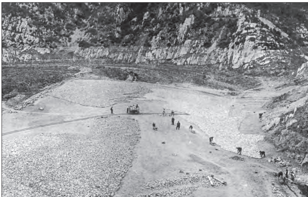
Zona del vas del pantà durant les tasques d'impermeabilització.
