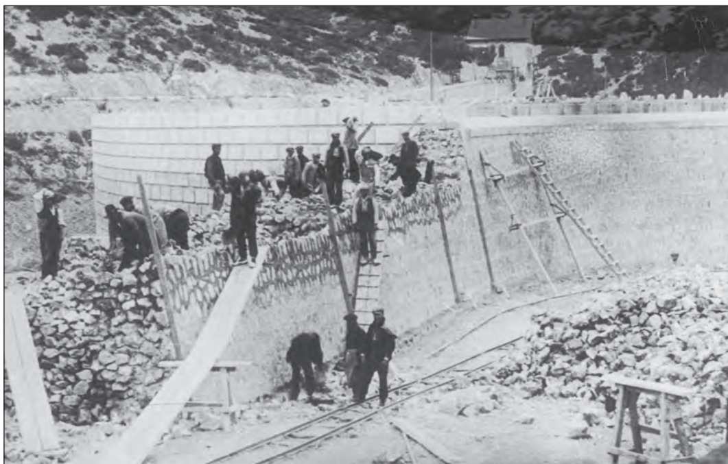
Diferents imatges del procés d'aixecament i coronació del mur de contenció de la presa.
