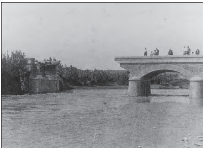
El pont de la carretera enfonsat per la riuada del 16 d'agost de 1921.
