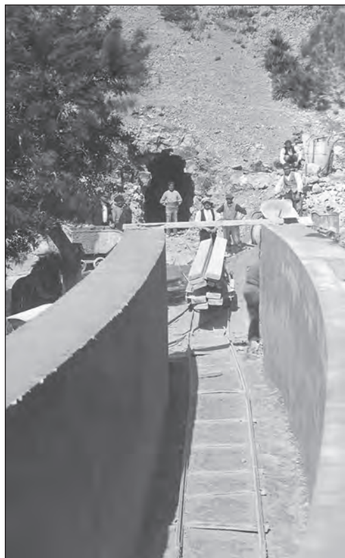
Diversos operaris treballant en les tasques del canals.
