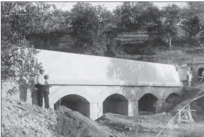
Diferents imatges durant la construcció dels canals i sèquies.
