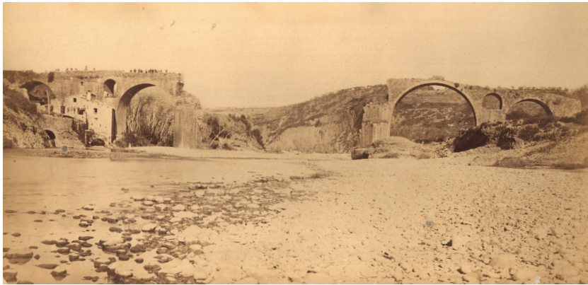
Fig. 13. Fotografia d'Amis Unal del pont d'Espionellà abans de la restauració (BAPP).
