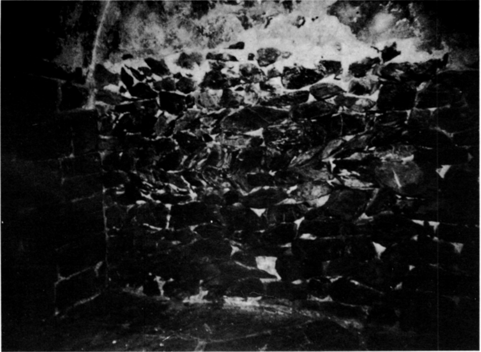
Detall de l'aparell pre-romànic del mur meridional de Sant Julià de Ribelles.
