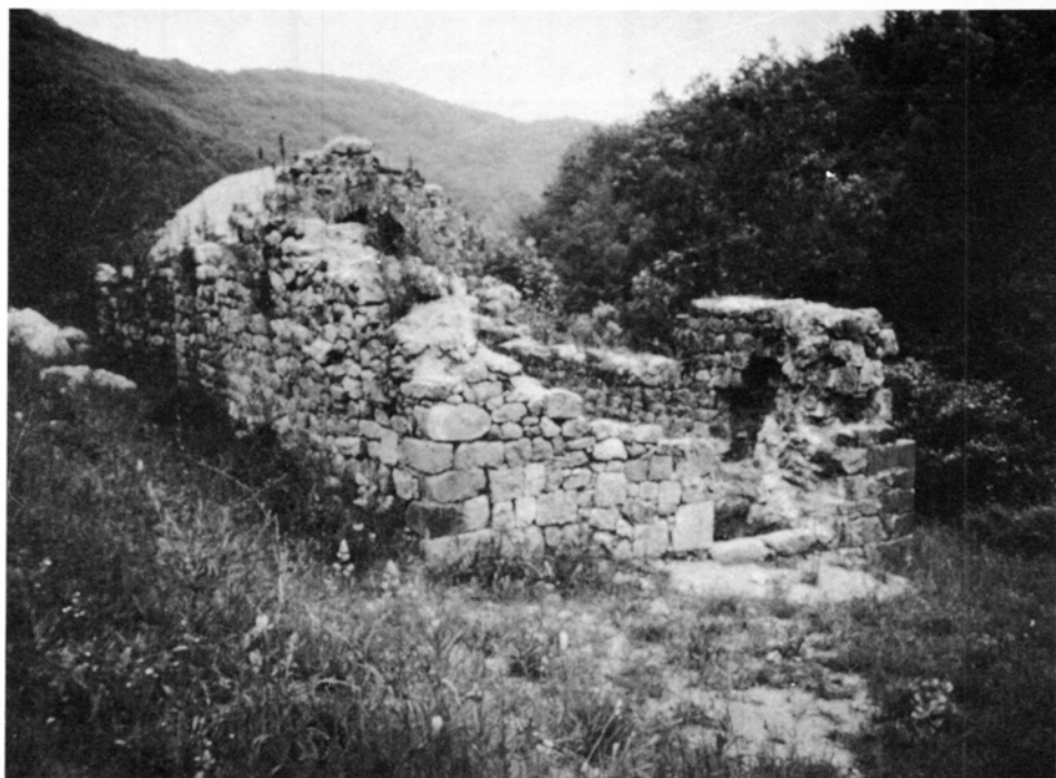
Les ruïnes de Sant Corneli de la Muga des de nord-oest. Es pot observar el canvi a l'aparell de la nau amb un fragment de filades seguides que correspon al segle XIII i altres amb pedres col·locades sense ordre, de refecció tardana.
