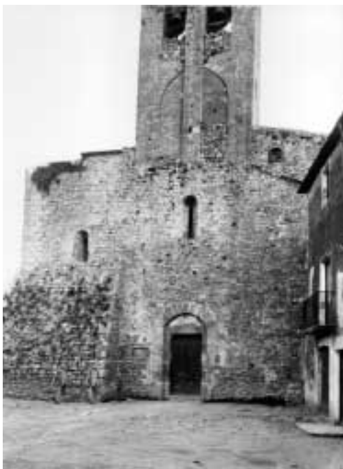
Façana de l'església parroquial de Santa Cecília de Terrades. Fotografia de l'any 1916, abans de la seva destrucció. (Foto Institut Amatller d'Art Hispànic, Arxiu Mas).
