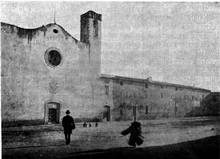
La Plaça de l'Institut fou aconseguida al desmontar-se les terres per omplir els fondals per on passava la via del tren.
