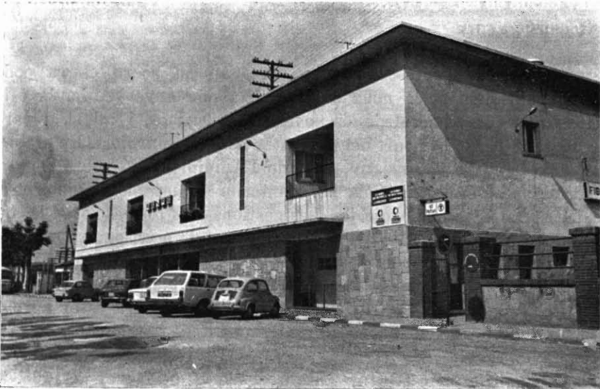
Façana de l'actual estació.
