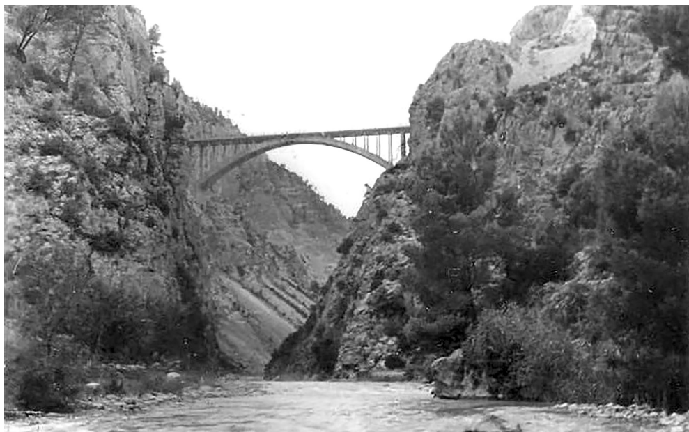
Puente sobre el río Turia, en el término de Santa Cruz de Moya (Cuenca), que permitió completar el itinerario de la carretera Valencia-Ademuz en la década de 1960.
