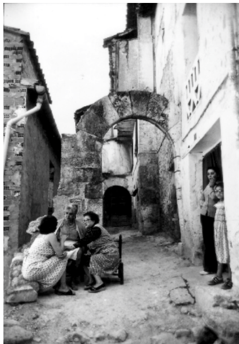
Calle del Horno. Ademuz. Década de 1960. Foto Mario Guillamón Vidal. Biblioteca Valenciana.
