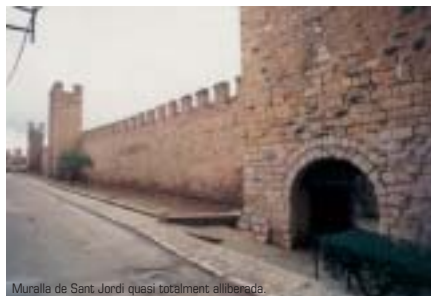
Muralla de Sant Jordi quasi totalment alliberada.
