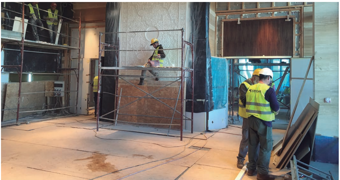
Els treballadors de Sindar es desplacen per tot el món per a fer el muntatge de les estructures creades.
