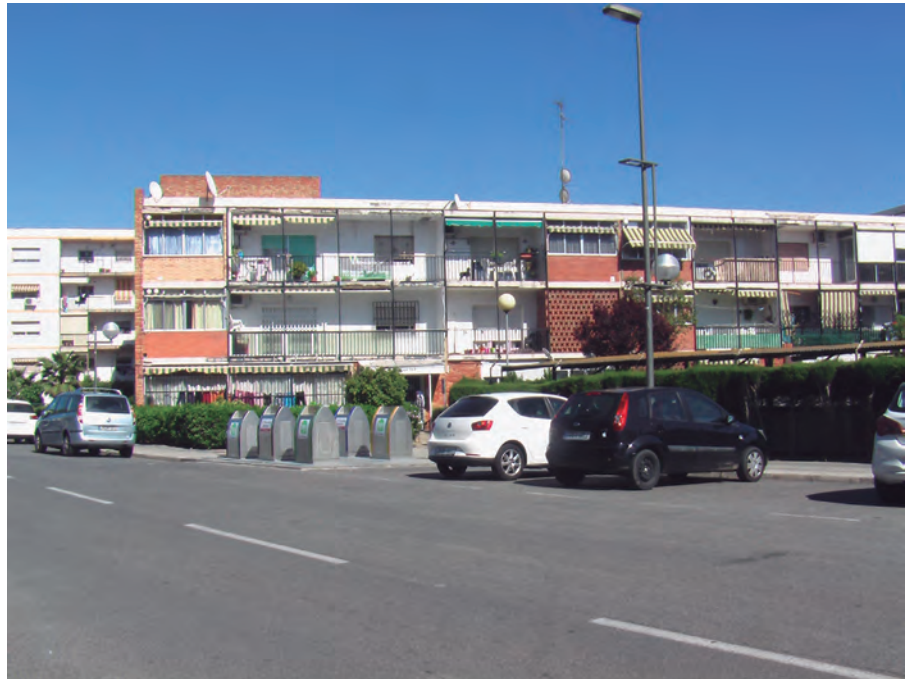
Part d'una façana dels blocs IQA a Torreforta, vista des del carrer Prades
