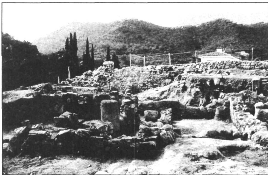
Vista del conjunt, des del costat est, abans de la construcció de la coberta (foto: Joan F. Clariana).
