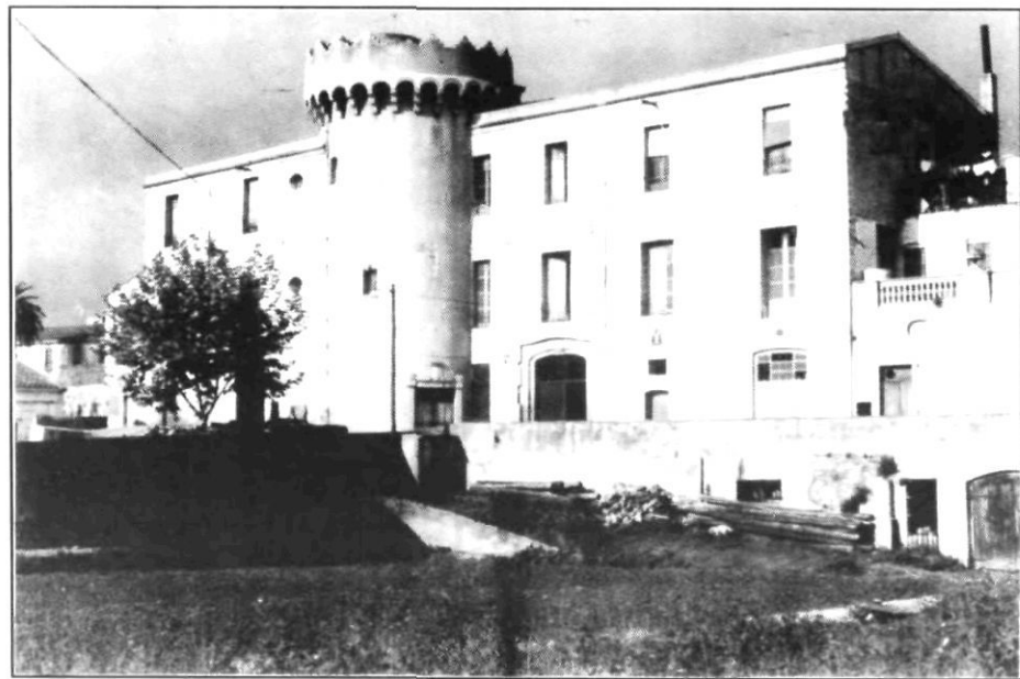
Vista general de la torre Llauder, després de les reformes de 1931.
