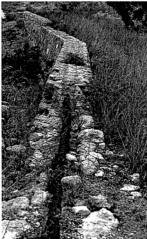
Aqüeducte per damunt d'un abarrancament. Camí de Salades.
