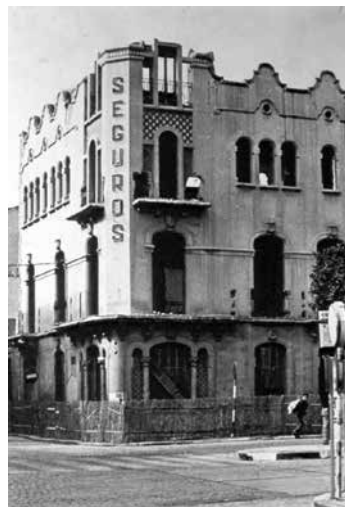
Fig. 13. Enderroc de l'edifici modernista conegut com «la Mutua» (autor: Castillejos)
