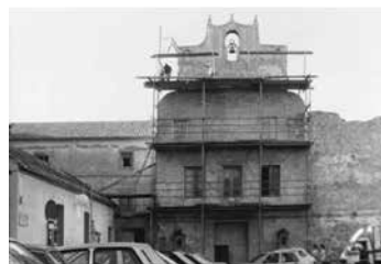
Fig. 4. Església de Sant Josep i convent dels franciscans. Façana nord.
