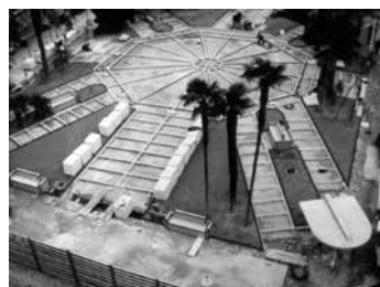
Fig. 15. Obres de reconstrucció de la Glorieta (1996)
