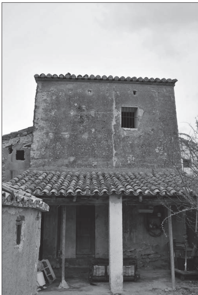
Làmina I. La Torre de Canor, costat W (font: els autors).
