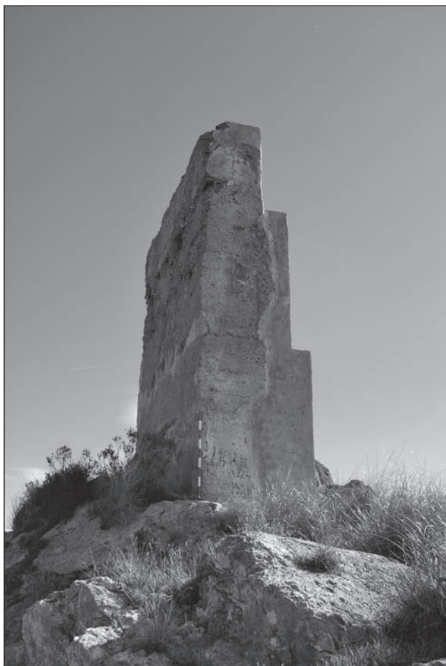
Làmina VIII. Llenç del Castellet del Mascarat (des del S) que resta en peu, en què s'observen les distintes tongades de tàpia (font: els autors).
