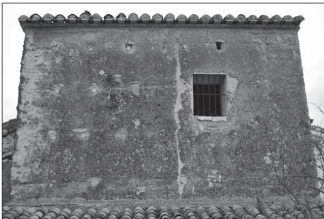
Làmina VI. Part superior de la façana W, en la qual s'observa la forma dels caixons de tàpia, i els negatius de les agulles (moltes tapades amb pedra i algeps) (font: els autors).
