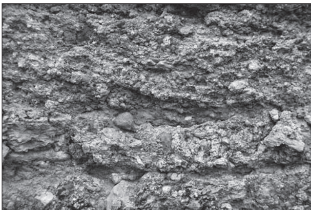
Làmina V. Detall del formigó de tàpia (font: els autors).
