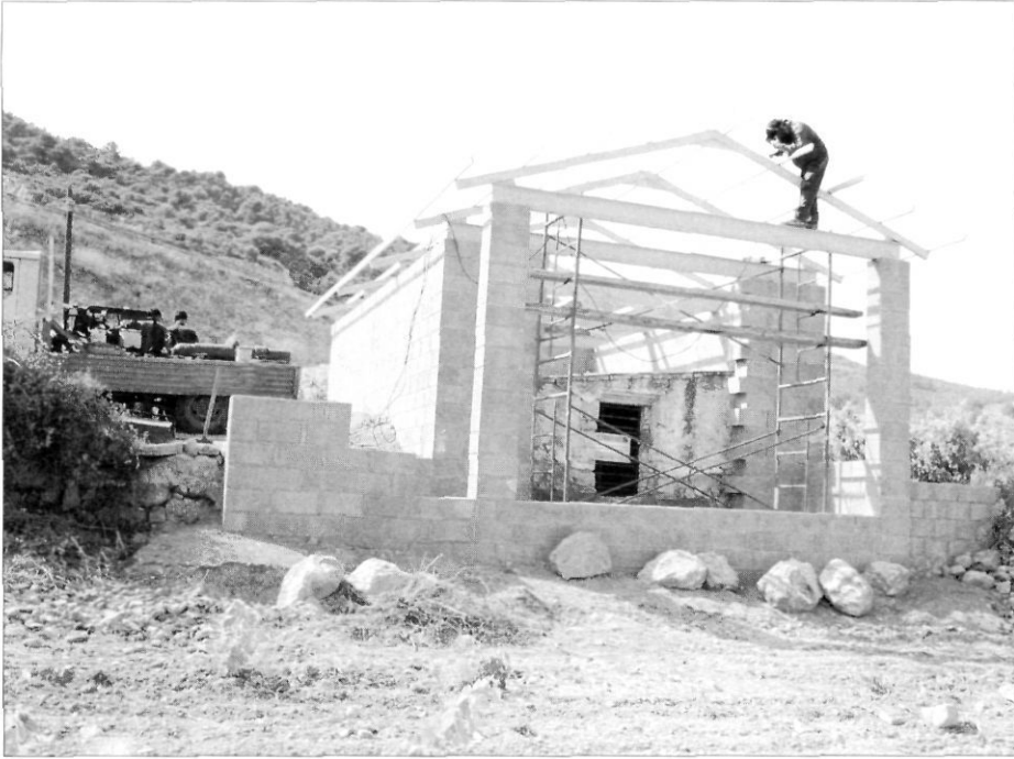
Obres de construcció del nou cobert de protecció al forn de Fontscaldes. (Foto: S. Burguete)
